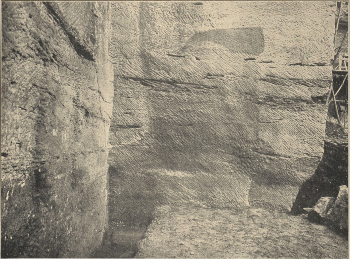
Abb. 9. Mit der Zweispitz abgearbeitete Felswand (Wand III).
