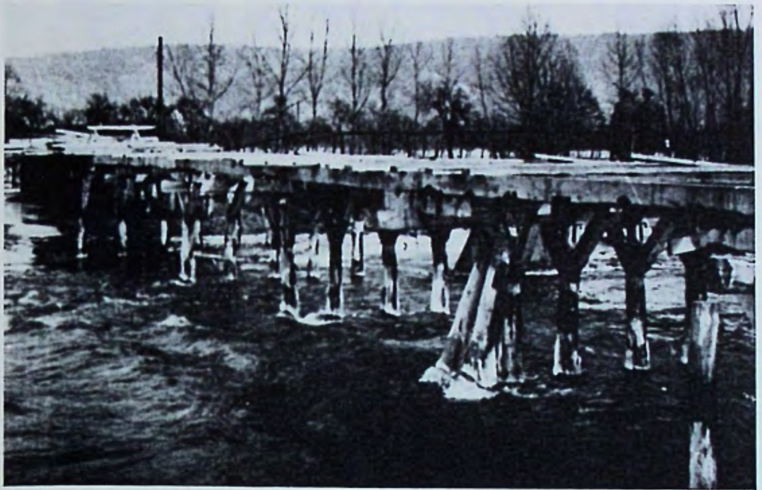
Die Pionierbrücke im Bau, 1940
