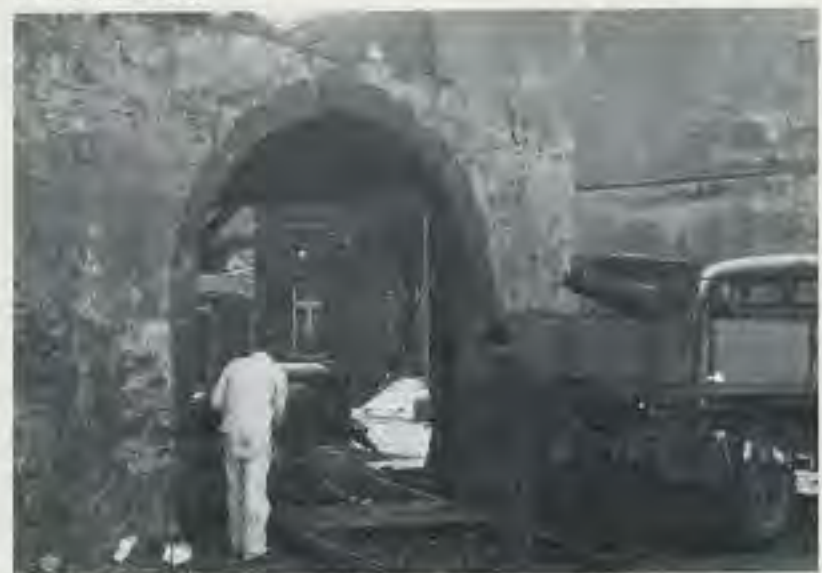
Das Zehnhoftor wird abgerissen (1965)
