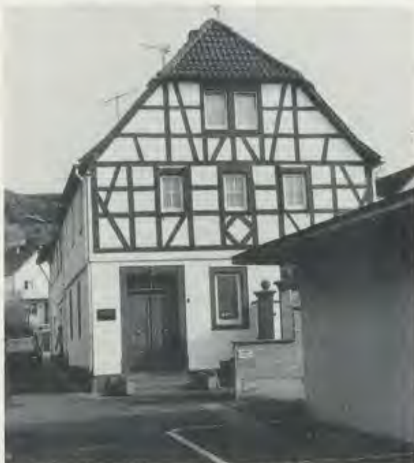
Das Kellergebäude des Andernrather Klosterguts St. Thomas, welches sich Pastor Fey 1802 vor Bau des Pastorats als Pfarrhaus wählte (Ellig Nr. 6, Aufnahme 1981)
