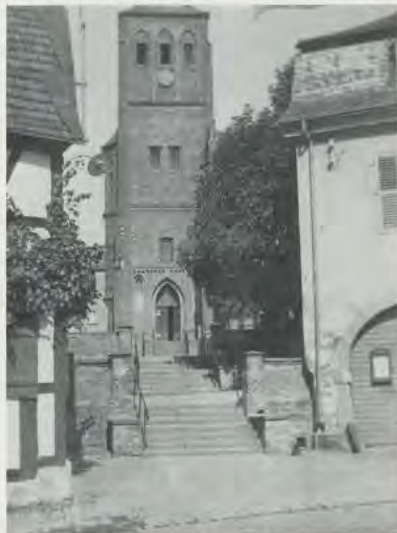
Aufgang zur Kirche vor dem Umbau (um 1960)
