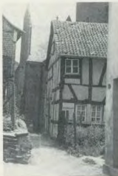
Hausidylle am Ellig – Alters Häuschen
