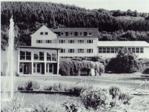
oben: Das Kurhaus mit der 1955 errichteten Trinkhalle darunter: Das Kurhaus nach dem Umbau 1957
