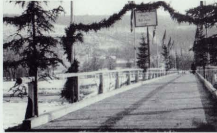
1940 bauten Pioniere neben dem Fußgängersteg eine befahrbare Holzbrücke, und nannten diese nach ihrem Kommandeur „Rothe-Ahr-Brücke“.
