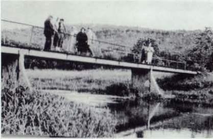
1921 entstand der eiserne Fußgängersteg.
