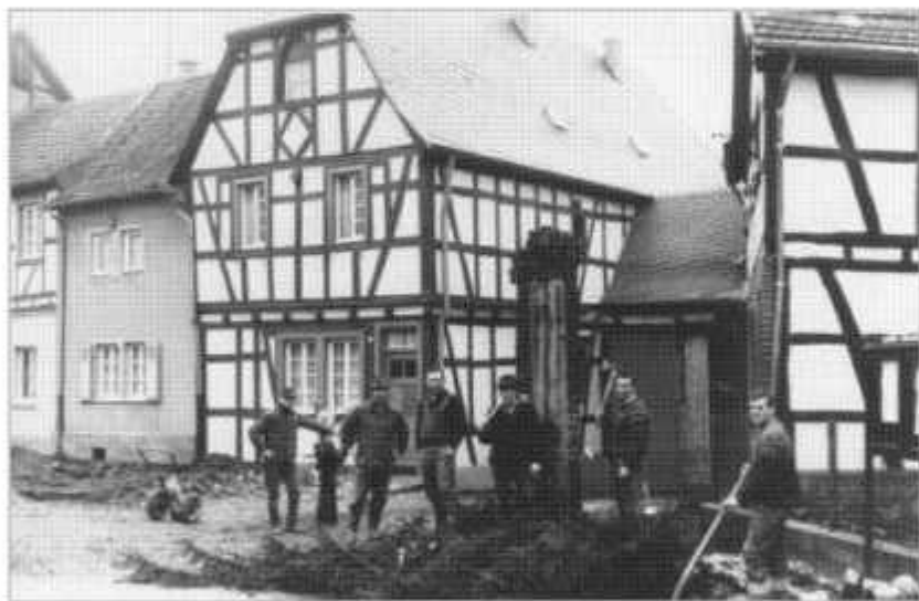
Arbeiten an der Pumpe in der Dorfmitte
