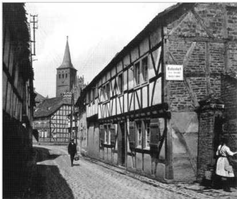
Obere Pforte mit Pumpe
