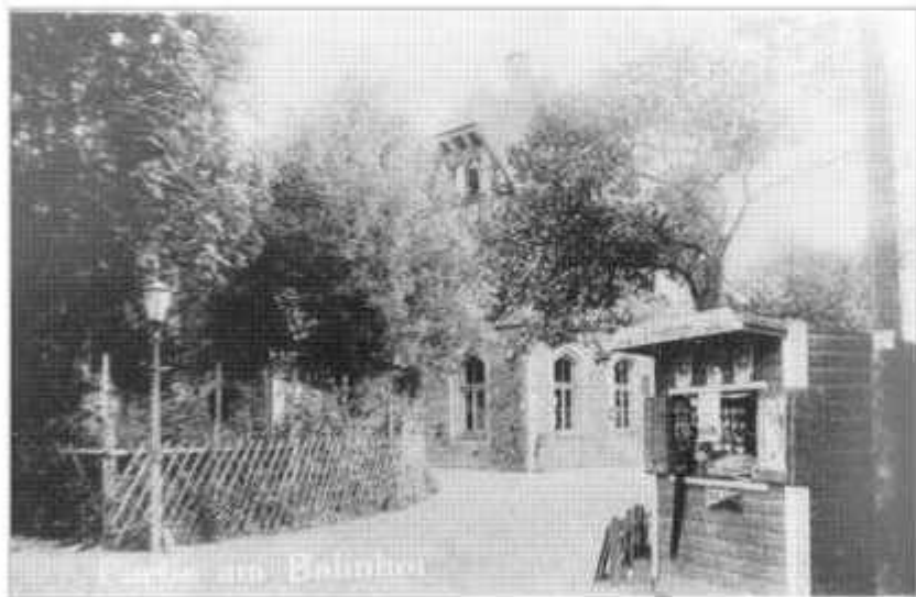
rechts Wiertze Büdche, links die Umzäunung um das ehemalige Nebengebäude, im Hintergrund Bahnhof und Wartesaal
