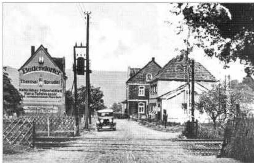
Der Bahnübergang, A-Mast links
