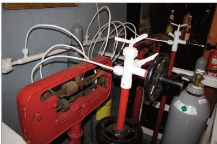
Bei einer Umgebungstemperatur von 20 °C entwickelte das flüssige CO<sub>2</sub> in den Stahlflaschen einen Druck von 57 bar.
