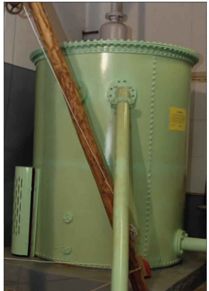
Alles was aus dem Bohrloch ent- strömte, wurde über das Förderrohr dem Abscheidetank zugeführt. Hier beruhigte sich die schäumende Flüs- sigkeit und wurde mittels einer Pumpe der Mineralwasserabteilung zugeführt.
