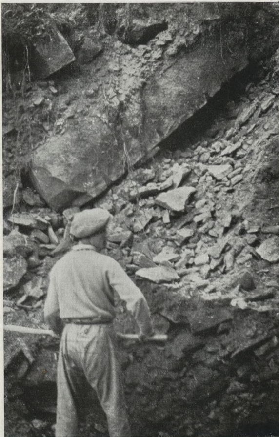
Abb. 11. Oberer Teil der Verschüttung in der östlichen Brunholdisstuhlmitte. Darunter gleiches Material, wie in den Ringwalldurchstichen gefunden wurde.
