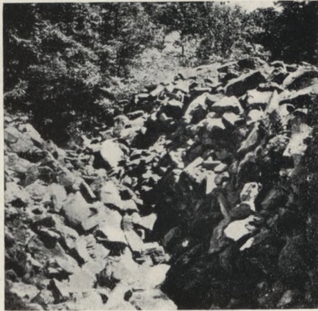
Abb. 5. Die Aufschüttung des Walles der Ringmauer.
