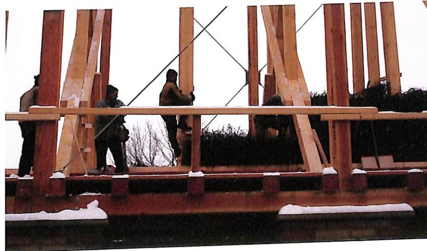
Das Reisig wurde zunächst lose eingebaut, dann in jeweils ca. 60 cm Höhe festgetreten und anschließend durch horizontale Dornriegel verdichtet. Danach erfolgte der Schnitt und die Glättung der dem Umlauf zugewandten Seite mit einem speziellen Klopfbrett.
