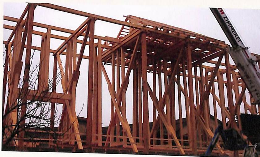
Wie zuvor die Holzrahmen wurden auch die Dachkonstruktionen am Boden vormontiert, anschließend mit dem Kran auf die Holzrahmen gesetzt und dort verschraubt.
