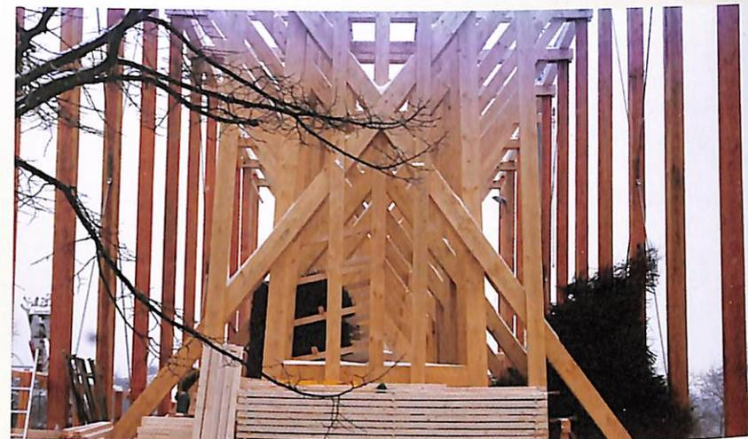
Ebenso wie die Zimmerarbeiten wurde auch der Einbau des Reisis im Süden begonnen und stetig in Richtung Norden fortgesetzt. Der Bereich der beiden Türme wurde dabei ausgespart. Eine Besonderheit ist die erstmals in neuerer Zeit durchgeführte Bedornung in einer geschlossenen Fläche, bei der die senkrechten Stützen und Dornriegel ebenso wie die waagrechten Hölzer zum Pressen und Fixieren des Reisis nicht sichtbar sind.
