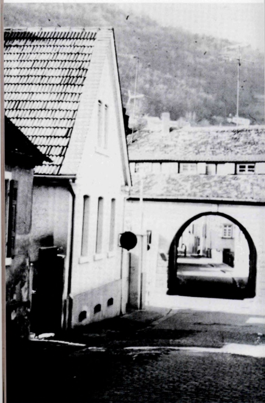
Gartenstraße mit Blick auf das Gerbhaus (Städt. Verkehrsamt)
