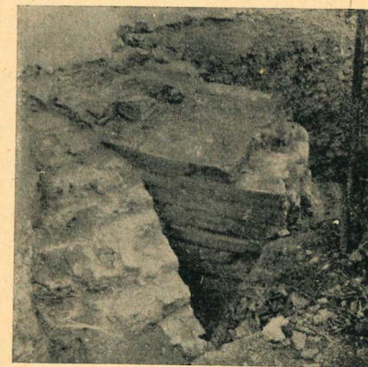
Abb. 6 — Nordapsis von außen; 1. am Rand: Hauptapsis, dazwischen Grundmauern einer nach Abbruch der N-Apsis gebauten Kapelle.
