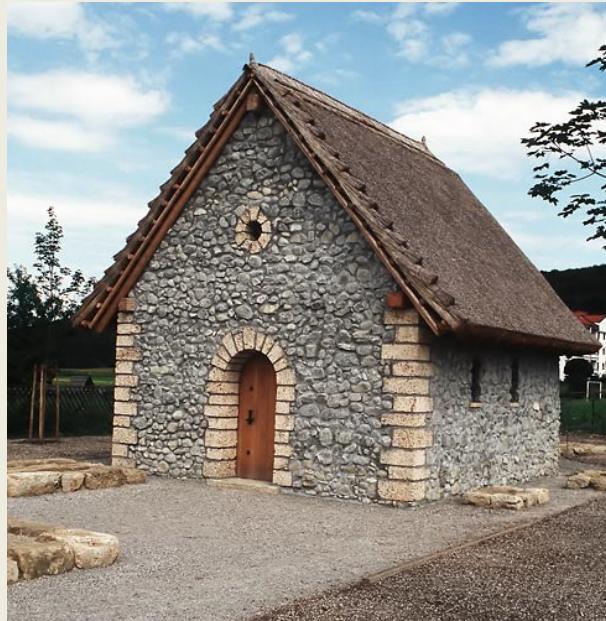
Beispiel einer fränkischen Kirche, Herrsching am Ammersee, Lkr. Starnberg, Oberbayern. Begehbare Rekonstruktion einer einschiffigen kleinen Saalkirche mit halbrunder Apsis der Mitte des 7. Jahrhunderts (Foto: Dr. Erwin Keller, Bayerisches Landesamt für Denkmalpflege)
