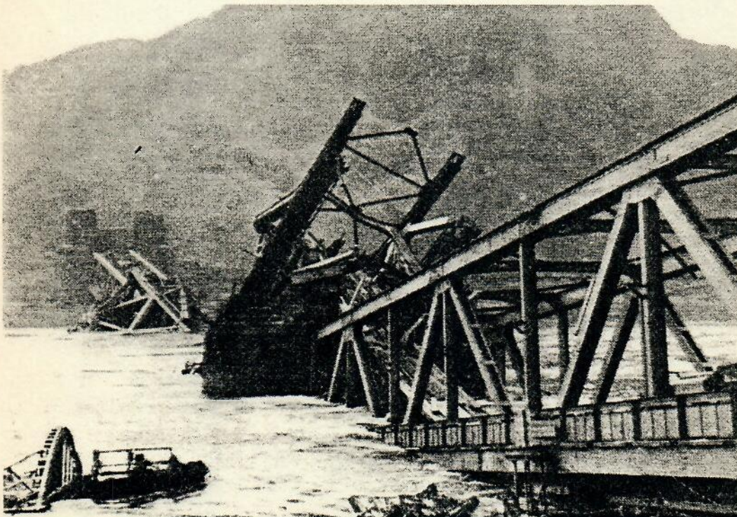
Die Remagener Brücke nach dem Einsturz.
