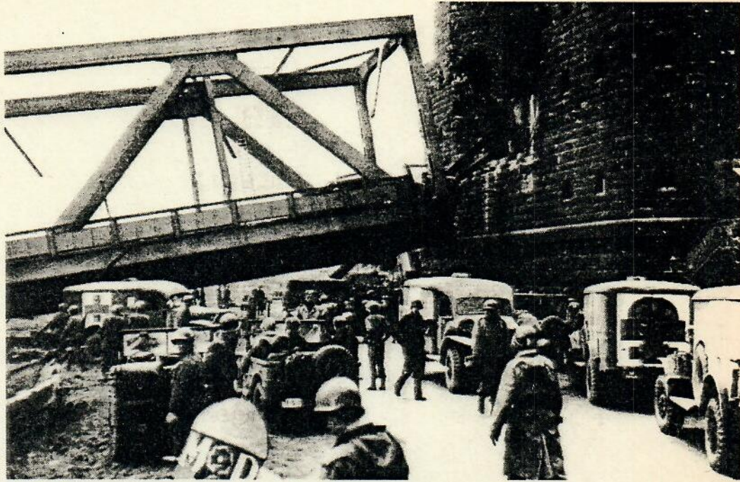
Die »Brücke von Remagen« nach dem Einsturz am 17.3.1945. 28 amerikanische Soldaten fanden den Tod.
